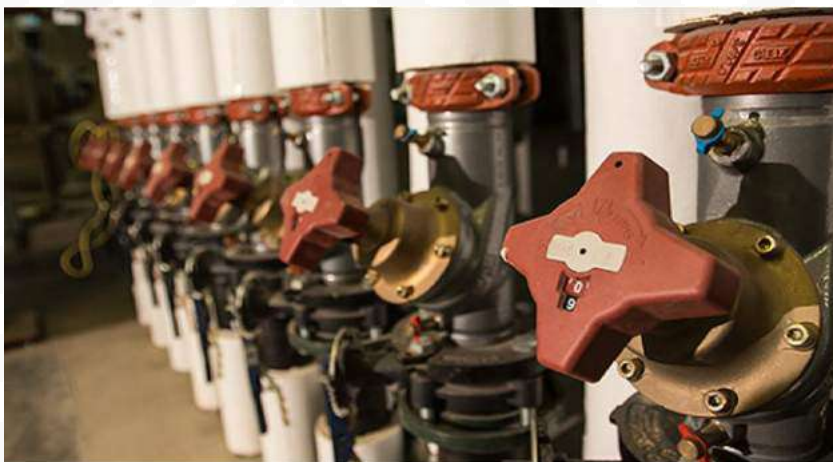
運用「地源熱泵」系統， 地底管線維持冬暖夏涼
