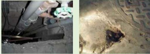
地下室污水池及孔洞破裂
